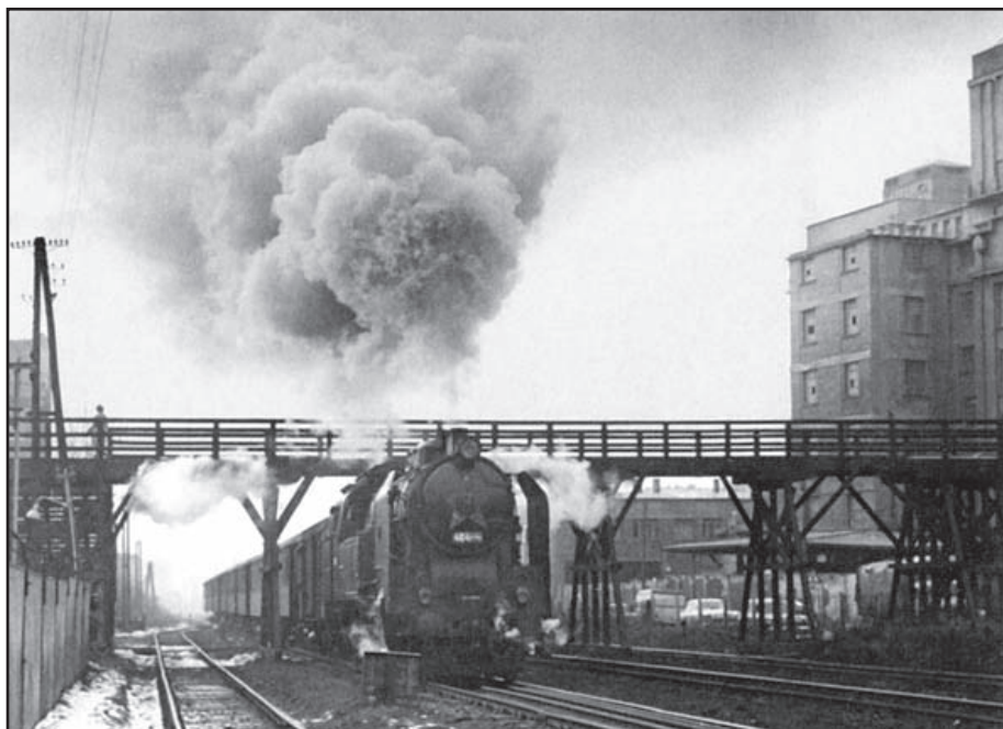
Dřevěná pěší lávka (vpravo Odkolkovy mlýny) nahradila původní železniční přejezd mezi ulicemi Ke Klíčovu a východním koncem Královské třídy (Sokolovská), dnes zvaného Pod Pekárny; 1968
