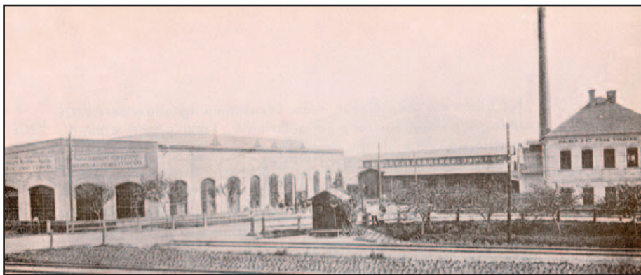
Týž pohled o rok později; továrna přistavěla kotelnu, vlevo původní železniční přejezd v ulici Ke Klíčovu
