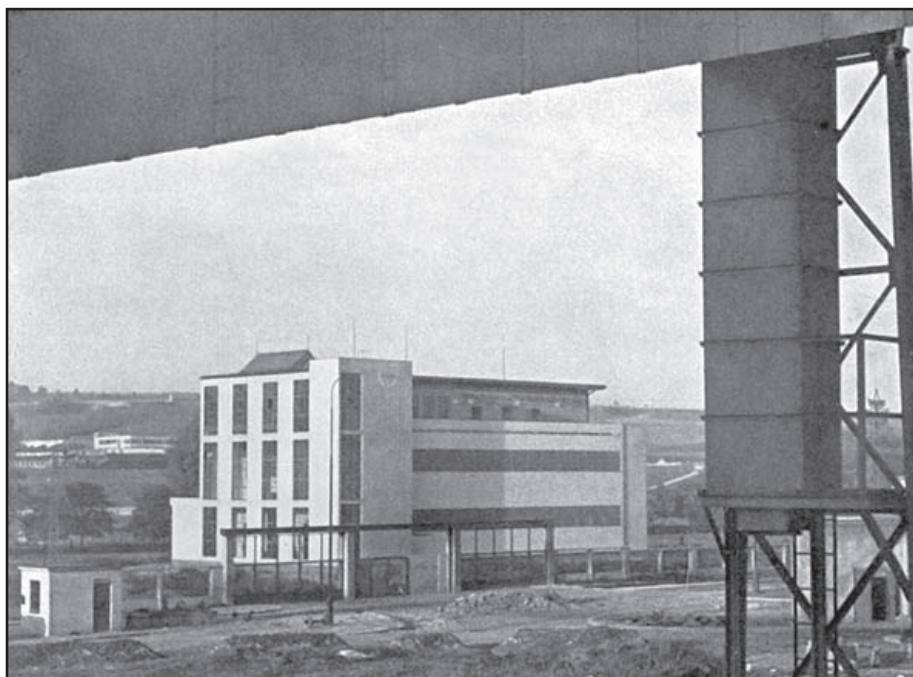
Usměrňovací stanice při pohledu od spalovny; v pozadí se zdvihají kbelské svahy
