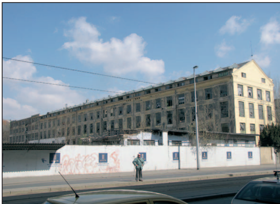
Sklad strojů; jeho dlouhý trakt končí vlevo vzadu halou expedice, skrze níž procházejí koleje vlečky
