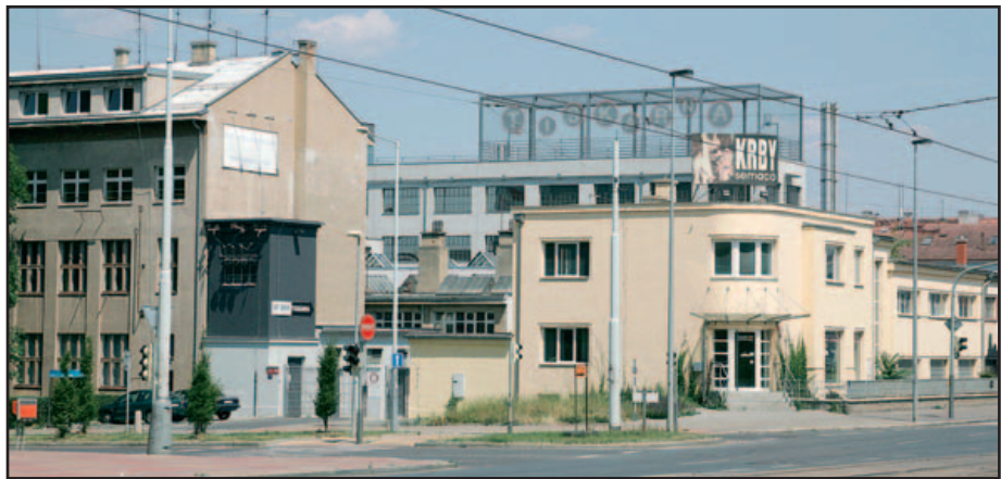
Vpravo oblé nároží dřívější Weissbergerovy továrny, vlevo Škola Zemské jednoty společenstva kovářů a podkovářů v Čechách – pozdější Masarykova škola kovářská, dnes kovářské učiliště; od této školy vzala své jméno zdejší ulice Podkovářská; v pozadí střešní hřiště na basketbal
