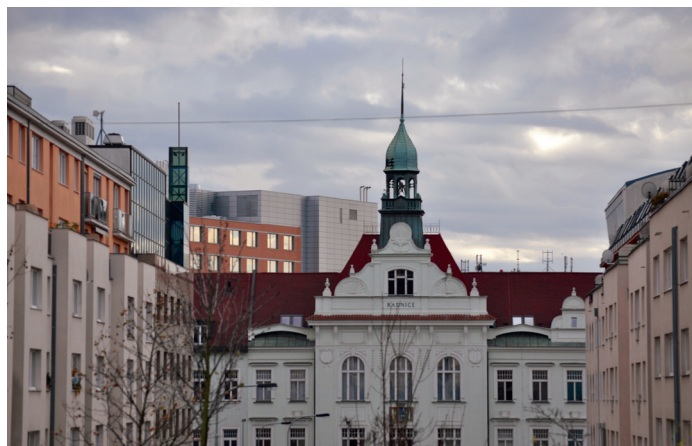
Radnice ve Vysočanech – pohled od nádraží
