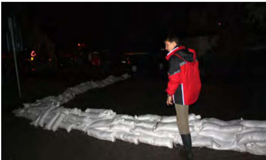
Protipovodňová hráz v Hrdlořezích
