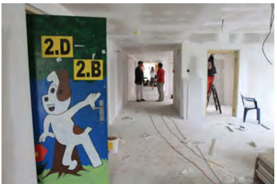
Rekonstrukce družiny v ZŠ Novoborská
