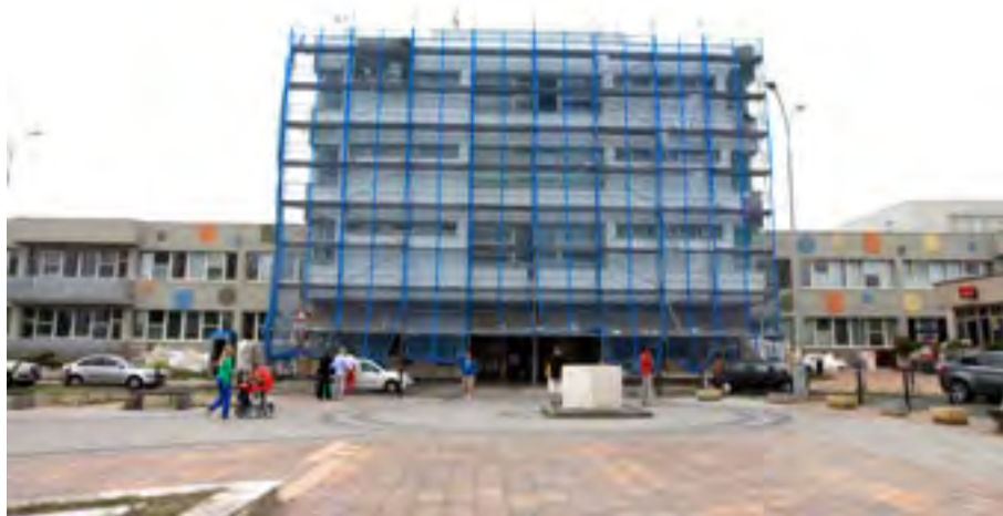
Rekonstrukce Polikliniky Prosek
