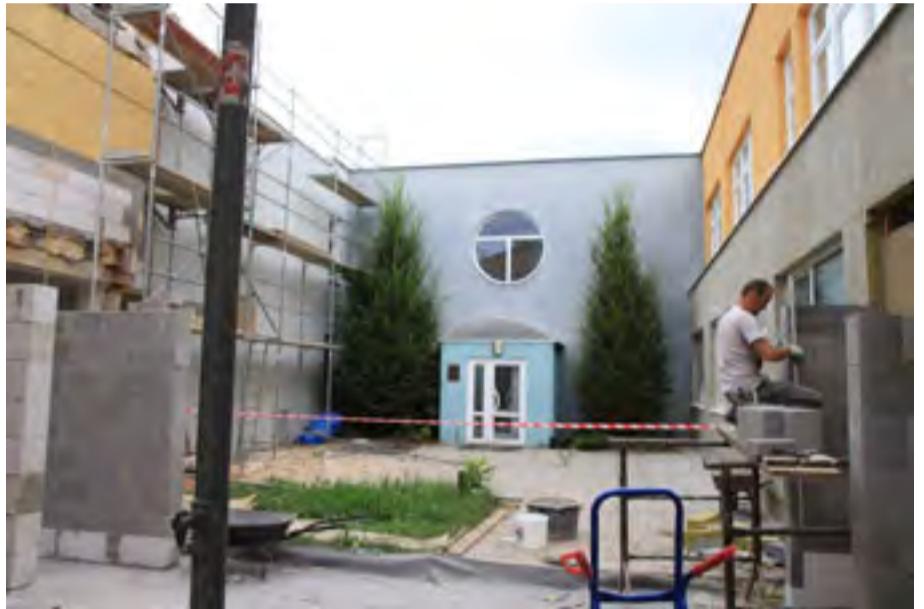
Přestavba částí ZŠ Spektrum na mateřskou školku
