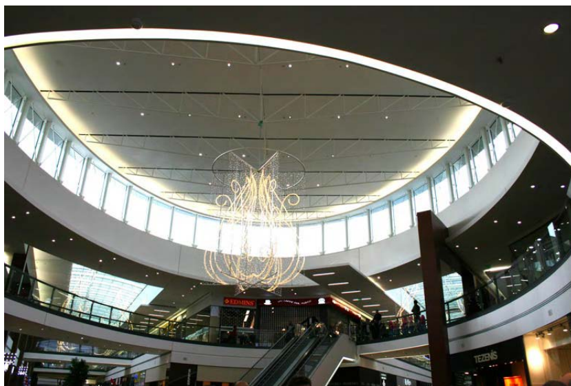
Pohled na ochoz v prvním podlaží centrální haly galerie
