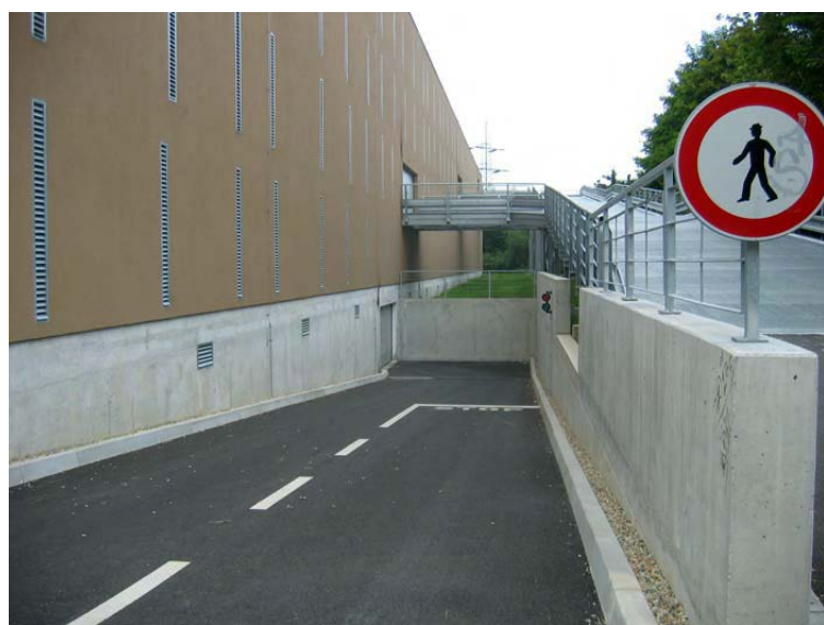
Garážový dům v Lovosické ulici - vjezd do garáží
