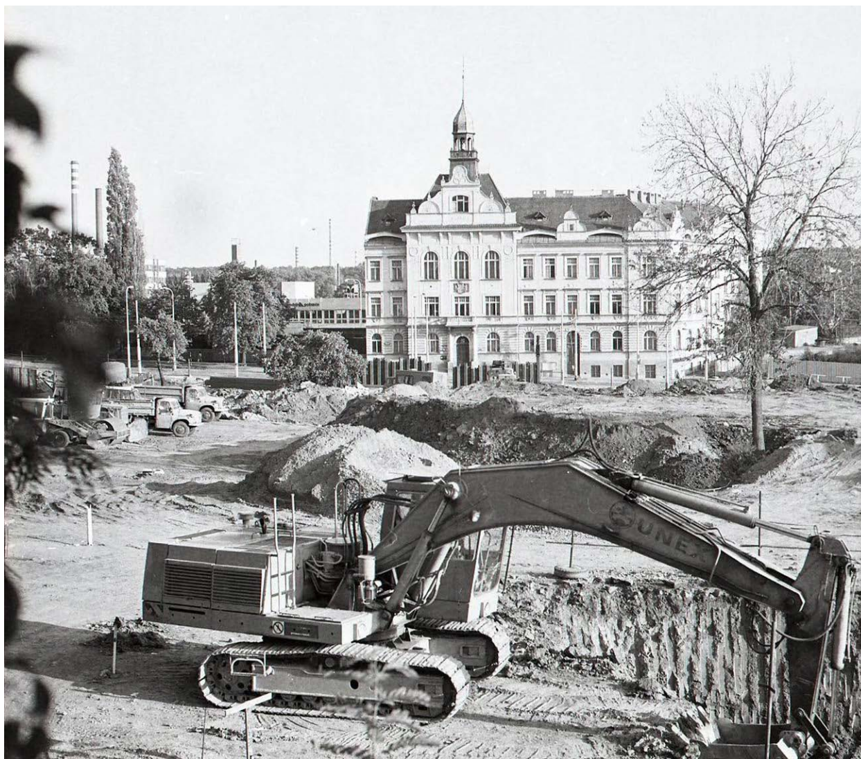
Z průběhu demolice tzv. přednádražního prostoru
