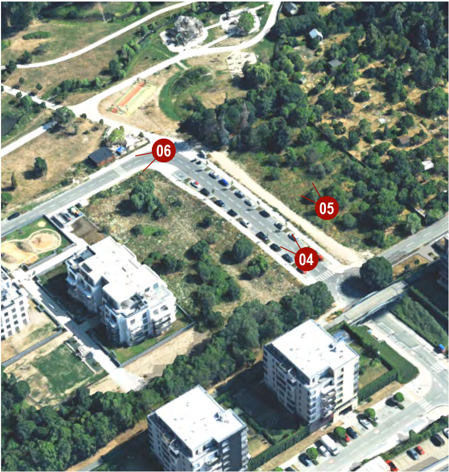
04 ulice Ivana Hlinky protínající řešené území 05 pohled z východní části k ulici Ivana Hlinky 06 kavárna, společenské centrum parku
