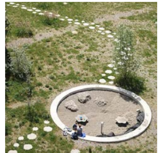
NÁŠLAPNÉ PLOCHY V TRÁVNÍKU JAKO POLOZPEVNĚNÁ STEZKA Wohnsiedlung Hardegg, Bern
