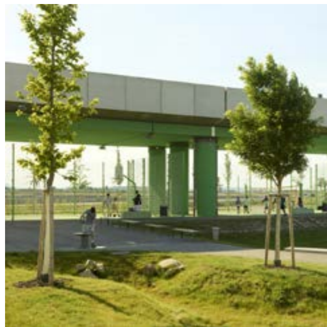
PŘEHLEDNÝ PROSTOR S ŘEŠENÍM MODROZELNÉ INFRASTRUKTURY Uniola, Elinor-Ostrom Park, Seestadt Aspern
