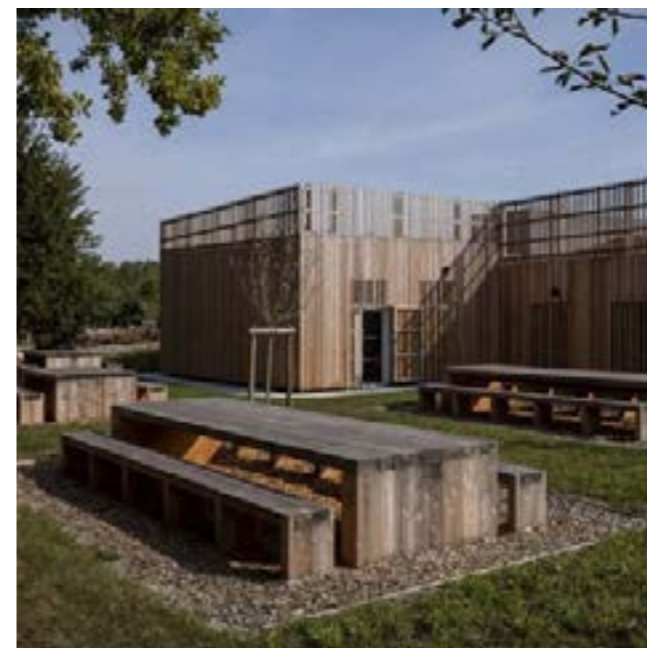
VEŘEJNÉ GRILOVIŠTĚ S KVALITNÍMI ODOLNÝMI PRVKY A MATERIÁLY Atelier Philippe Madec, Maison du Lac de Grand-Lieu
