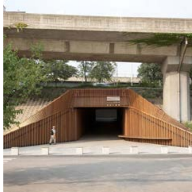
VIZUÁLNĚ ATRAKTIVNÍ MATERIÁLOVÉ PŘEVEDENÍ VSTUPU Haewon Shin Hangang Fußgängerunterführung_Seongsan, Seoul
