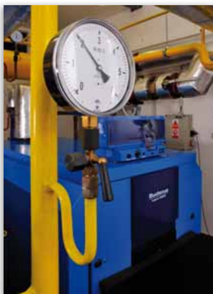
Kotelna Pod Strojírny
