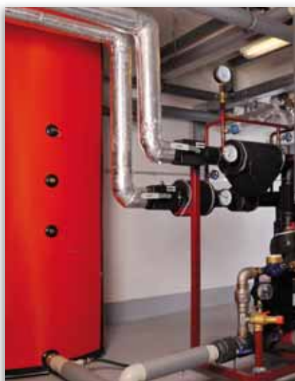
Výměňková stanice Na Vyhliďce
