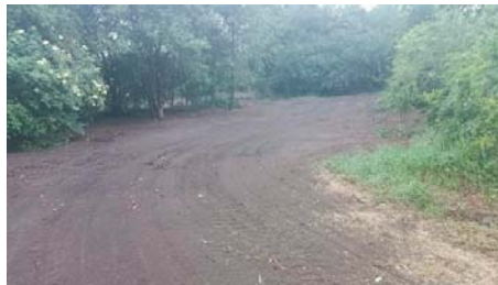
Prvním krokem revitalizace zanedbané lokality bylo vybudování nové cesty v délce zhruba 400 metrů
