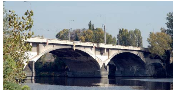
Vycházka od vyhlídky na Košince k Libeňskému mostu
