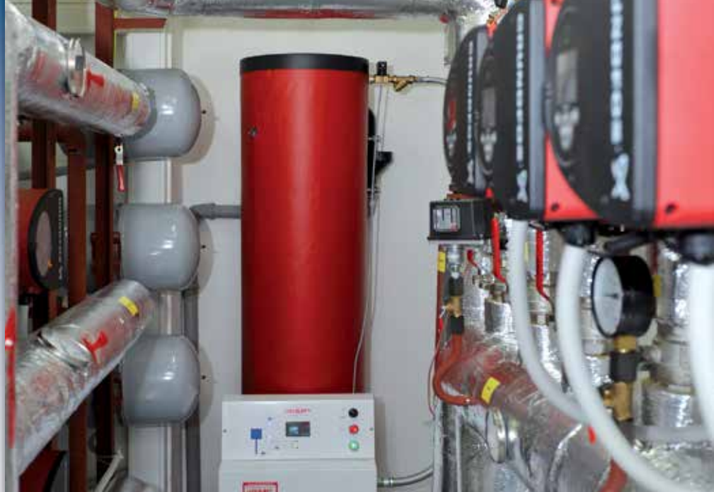
Automatická expanzní nádoba OLYMP v plynové kotelně Kolbenova 18
