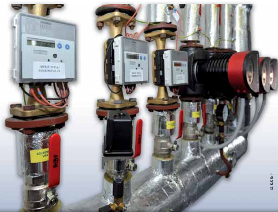
Měřiče tepla na výstupu z kotelny
