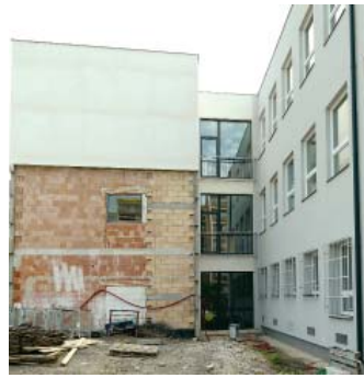
Přestavbou nevyhovující tělocvičny vzniklo šest nových tříd...
