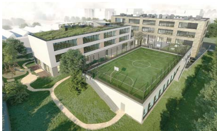
Základní a mateřská škola U Elektry bude první velkou od základů postavenou školou v posledních desetiletích v Praze
