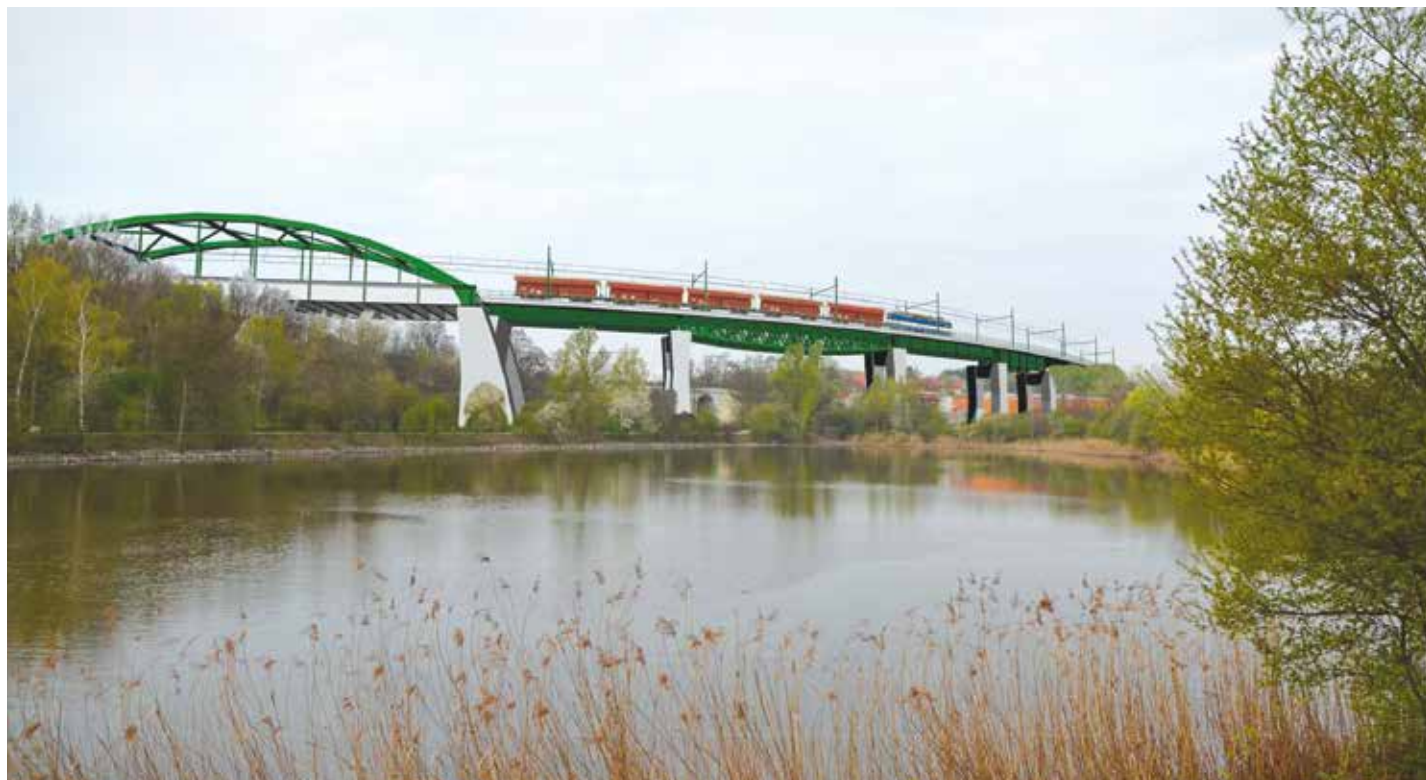
Pohled přes Hořejší rybník na železniční most ve st. km 2,212 (přesmyk)
