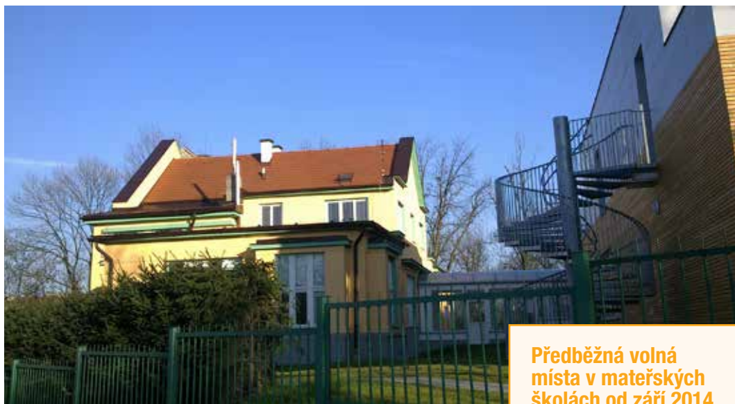
Budova Mateřské školy U Nové školy září novou fasádou
