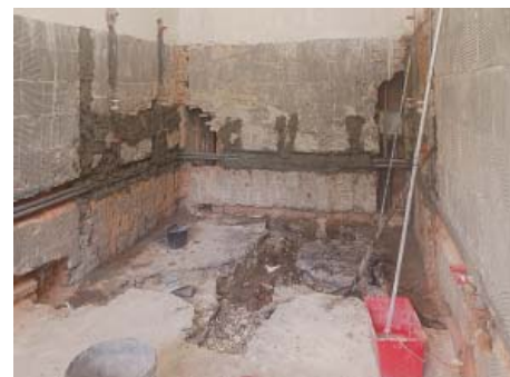
Jedna z řady letních oprav v Základní škole Litvínovská 500 se týká sociálního zařízení u tělocvičen
