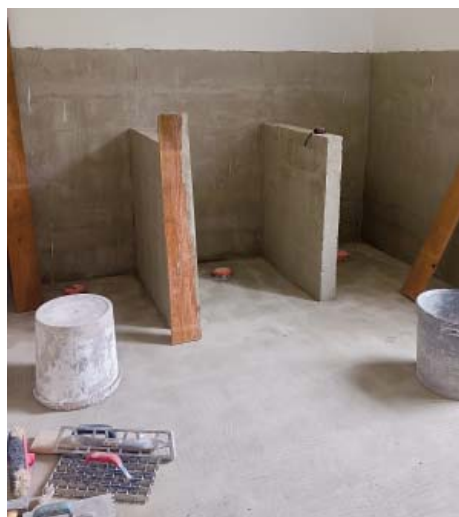
Oprava sociálního zařízení v Mateřské škole Kovářská
