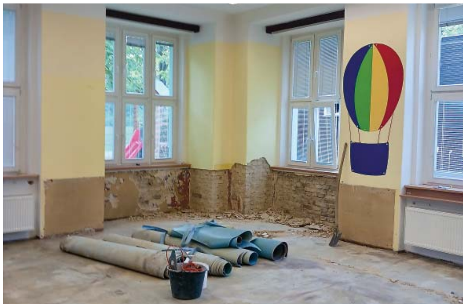
Ve škole U Nové školy se opravuje třída ve staré budově, podlaha v chodbě a zároveň tu plně ruče práce mají malíři
