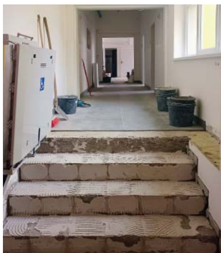
Investice do rekonstrukcí v Základní škole Novoborská patří v tomto období k největším v devítkových školských zařízeních
