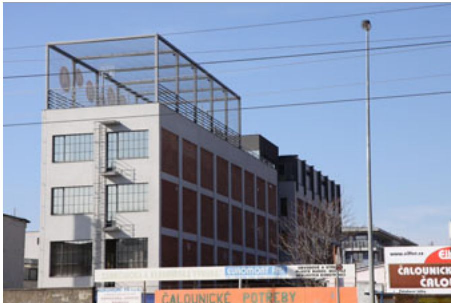
Přestavba tovární budovy
