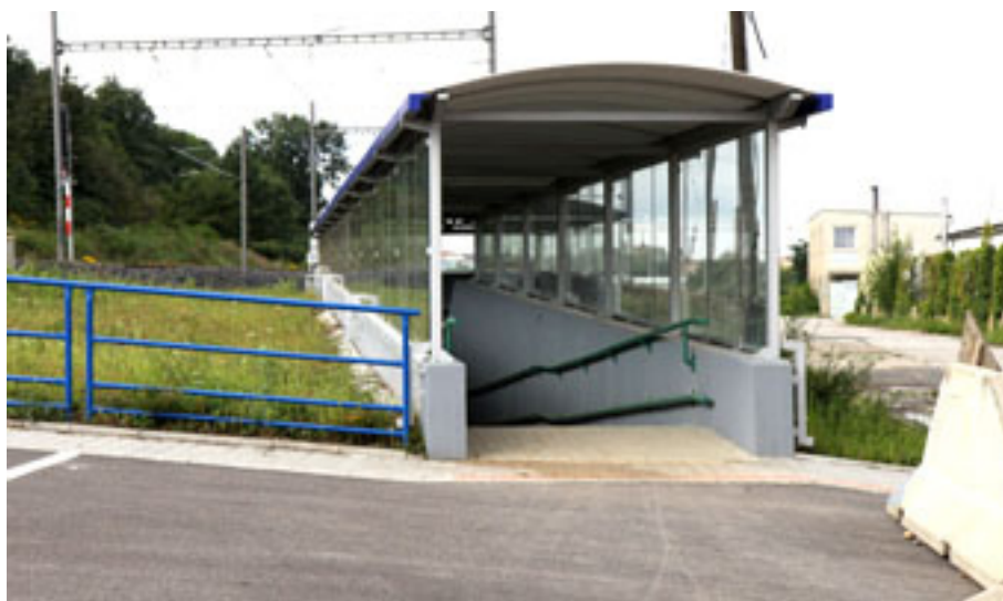
Podchod pod železniční tratí v Hrdlořezích
