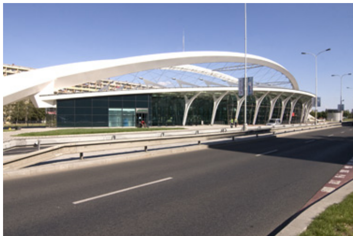
Stanice metra Střížkov
