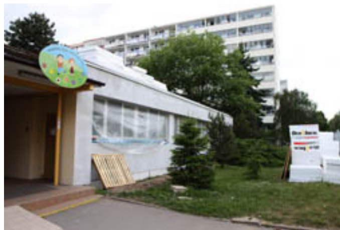
Zateplení MŠ obkladovým polystyrenem
