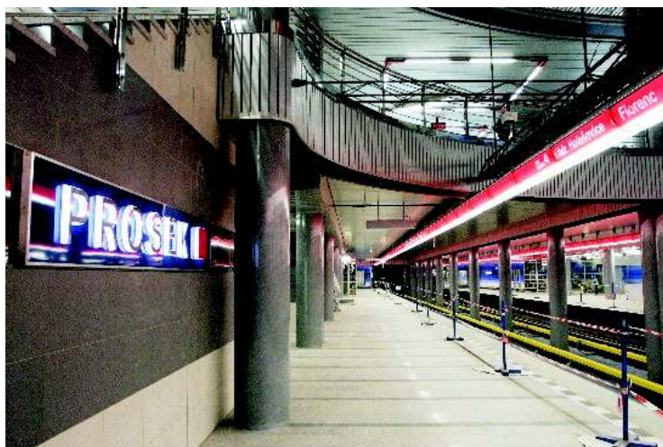
Nástupiště stanice metra Prosek
