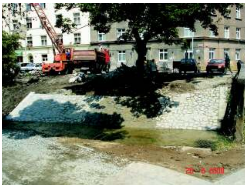
Zpevnování pravého břehu říčky Rokytky v ulici Na Břehu
