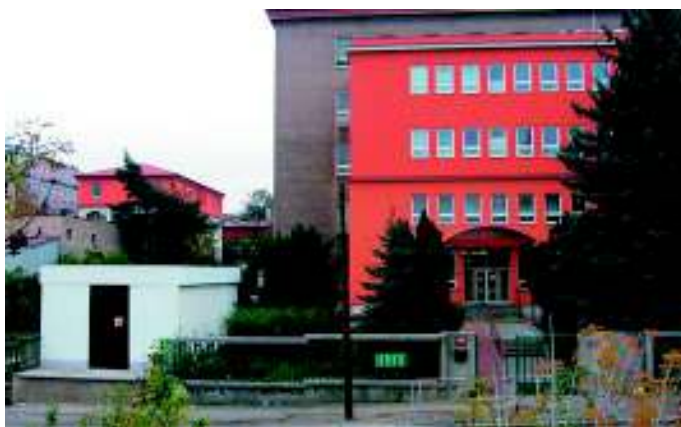
Střední škola slaboproudé elektrotechniky v Novovysočanské ulici je "celá nová"
