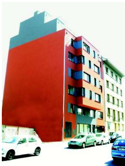
Bytový objekt z ulice Na Harfě
