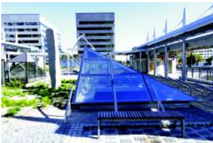
Několika prosklenými triangly vstupuje do stanice Prosek denní světlo
