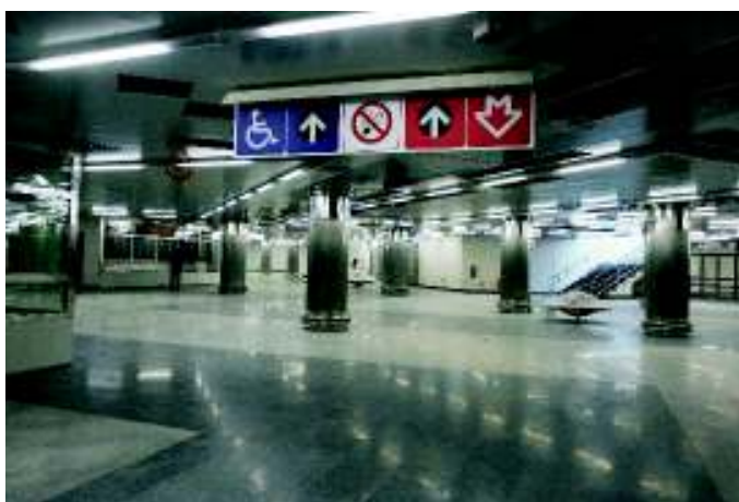
Vestibul stanice metra Prosek
