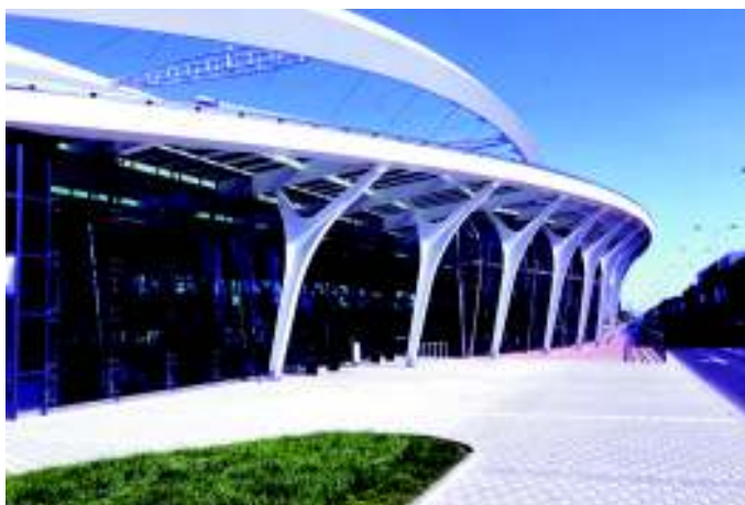
Průčelí stanice Střížkov do ulice Vysočanská
