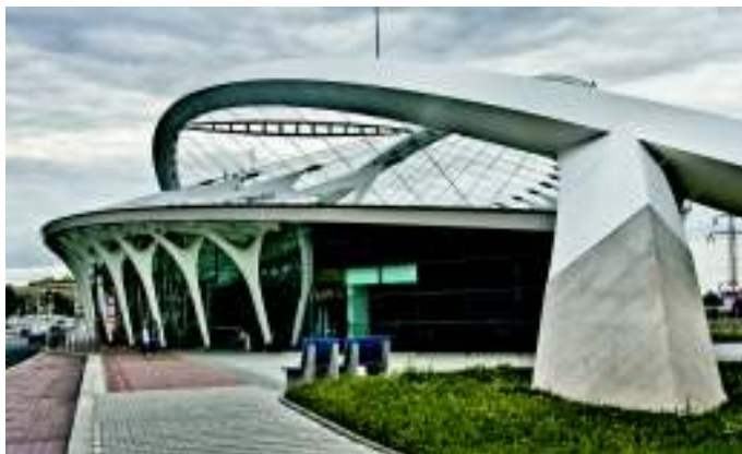
Pohled na stanici Střížkov z jihovýchodu
