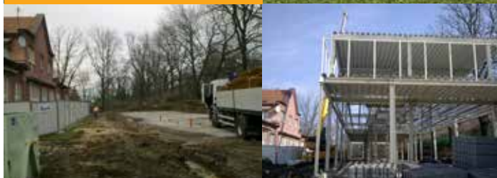
Hotová základová deska
