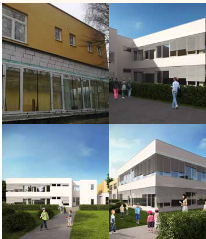
Dokončováno přízemí pavilonu C, které bude sloužit pro mateřskou školu i ZŠ Spektrum, s. r. o. V pavilonu A budou vybudovány 4 třídy mateřské školy. Vizualizace budoucího stavu
